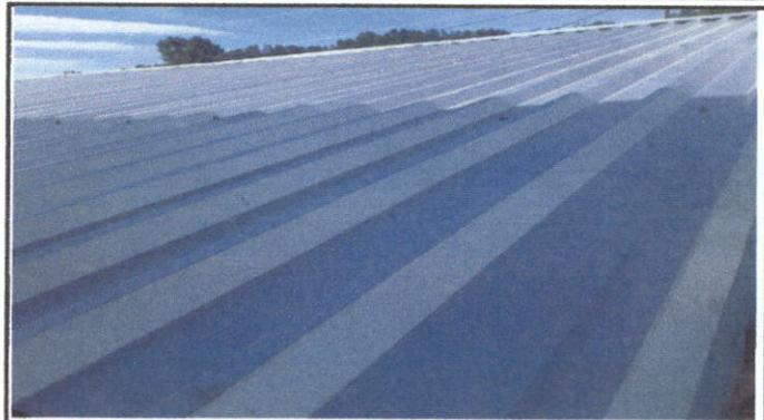
Foto 2: Sustitucion de lámina, por lámina troquelada aluzinc calibre 26. Modulo: 1, 2 y 3
